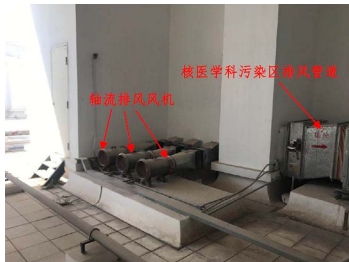
图 3-5 门诊综合大楼主楼 17 楼楼顶的核医学科污染区专用排风口
